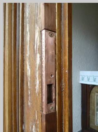
Das Schließblech war verrostet und wurde durch ein Kupferblech ersetzt.
