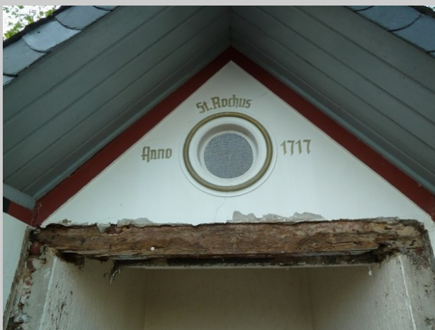
Beim Ausbau der alten Türe wurde dann festgestellt, dass der Holzbalken über der Türe stark geschädigt war.
