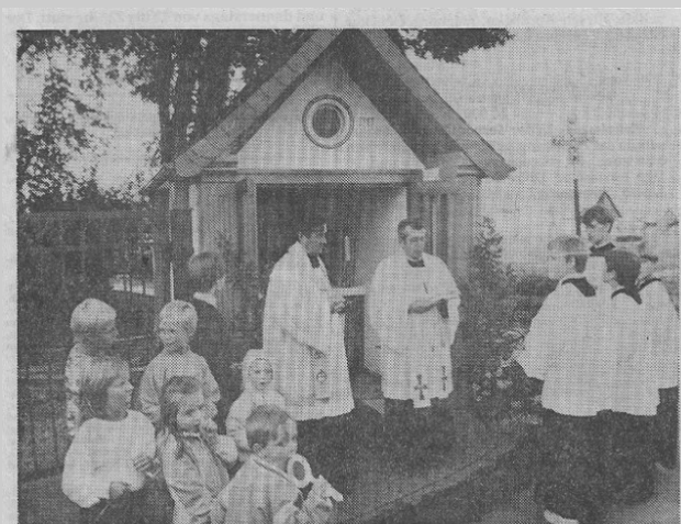
IN NEUEM GLANZ erstrahlt die kleine Rochus-Kapelle in Rath-Anhoven. Der Anstrich war nötig geworden, weil das Gebäude undichte Stellen hatte. Zwar sollten die Restaurierungsarbeiten bereits beim Wettbewerb „Unser Dorf soll schöner werden“ beendet sein, doch da die Kapelle aus dem Jahre 1717 unter Denkmalschutz steht, mußte zunächst die Genehmigung des Landeskonservators eingeholt werden. Neben dem neuen Außenanstrich wurden die Bilder, die zuvor auf Leinen gestickt waren, auf Metall aufgemalt. Und auch die Figuren wurden neu aufgearbeitet. So dient die historisch bedeutungsvolle Kapelle – sie war früher die erste Gebetskapelle für die Rafter auf ihrem Kirchgang nach Beeck – wieder dem ursprünglichen Zweck. Pastor Mirko Enderli(rechts) weihte die Kapelle gemeinsam mit Professor Dr. Vlavko Platz ein. Die Materialkosten übernimmt die Stadt, die Restkosten teilen sich der Kirchenvorstand, der Verein für Gartenkultur und Ortsverschönerung, die Bruderschaft St. Rochus und der Dortausschuß. RP-Bild: Schophoven
