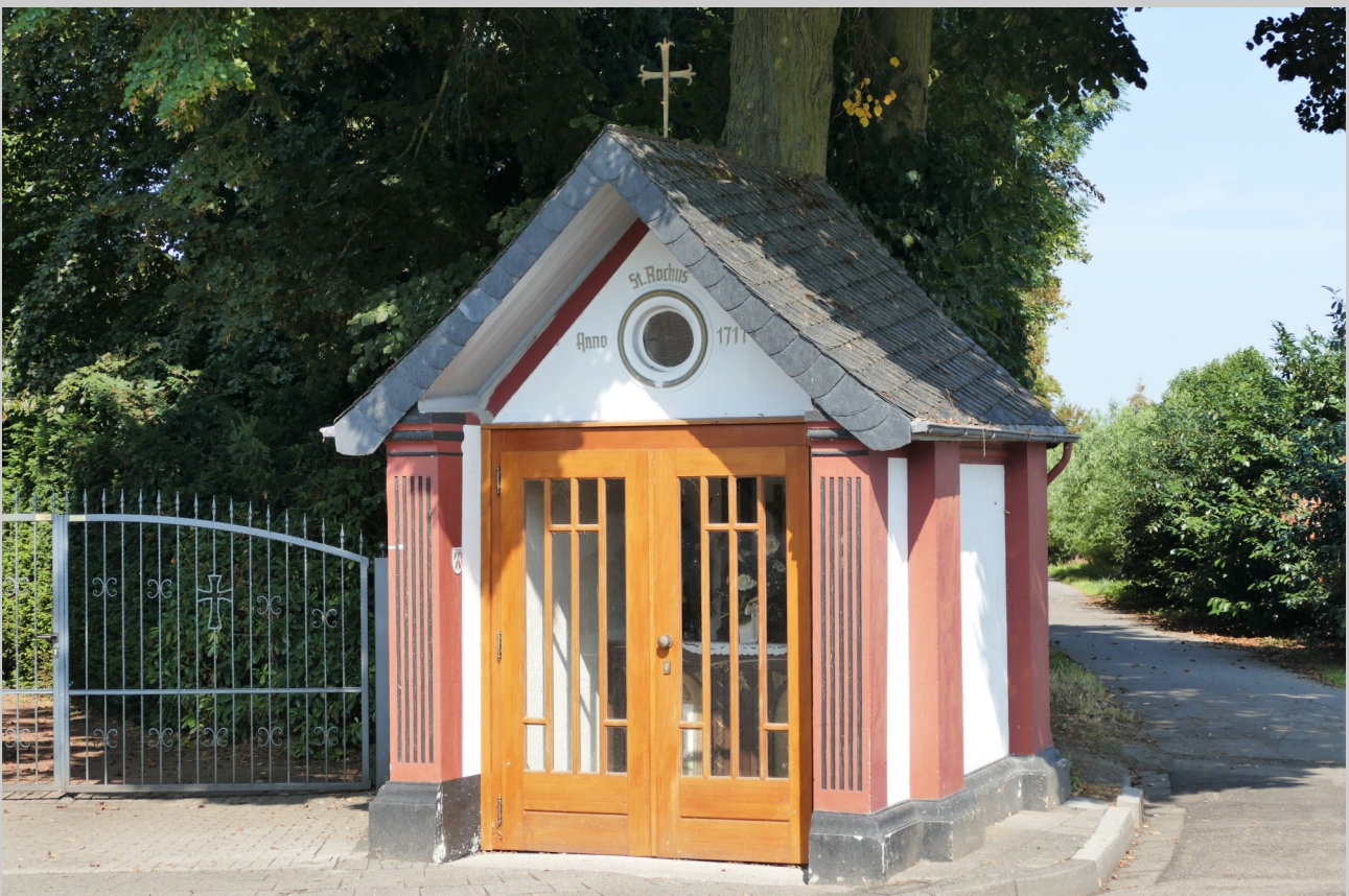
Aktueller Zustand Oktober 2017: Die Spuren des Türeinbaus sind verschwunden. Die neue Türe strahlt im herbstlichen Sonnenschein.
