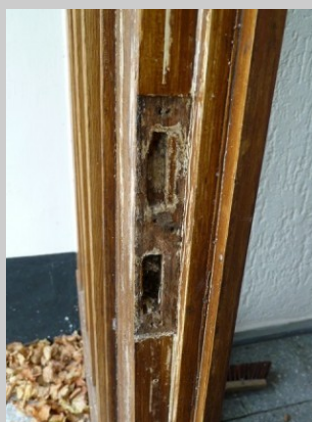
Das Schließblech war verrostet und wurde durch ein Kupferblech ersetzt.
