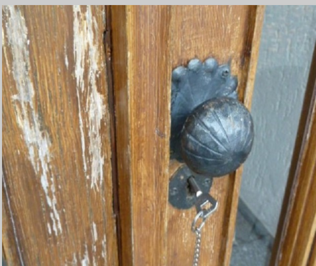
Es sah zwar nicht schön aus, aber zumindest war der Spalt nun mittels einer Leiste geschlossen und die Türe ließ sich wieder verlässlich verschließen.
