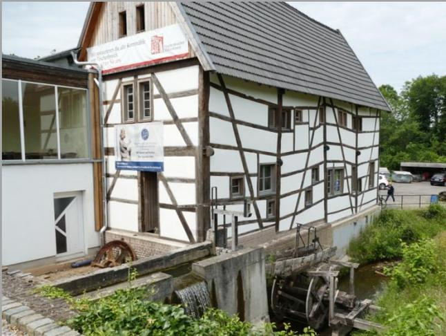
Der Zustand des Gebäudes aus dem 17. Jh. war vor Beginn der Sicherungsmaßnahmen Besorgnis erregend. Die Fachwerkstruktur war durch eindringende Feuchtigkeit erheblich beschädigt und verformt.
